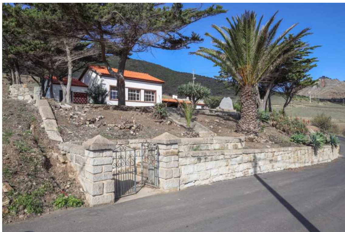
FOTOGRAFIA 4. ANTIGA ESCOLA DA SERRA DE FORA
